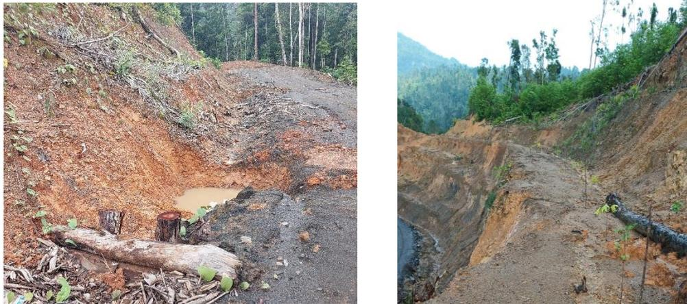
*Gambar 3. Sediment Trap dan Pembuatan Teras Penahan Longsor*
